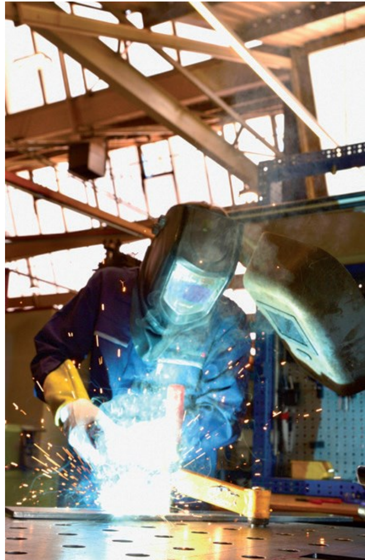
現場で加工中のエンジニアの様子
